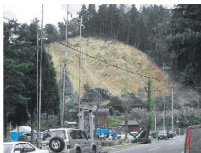
新潟県中越地震の土砂災害現場
