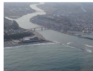
研究フィールドの1つである那珂川河口域の概景
