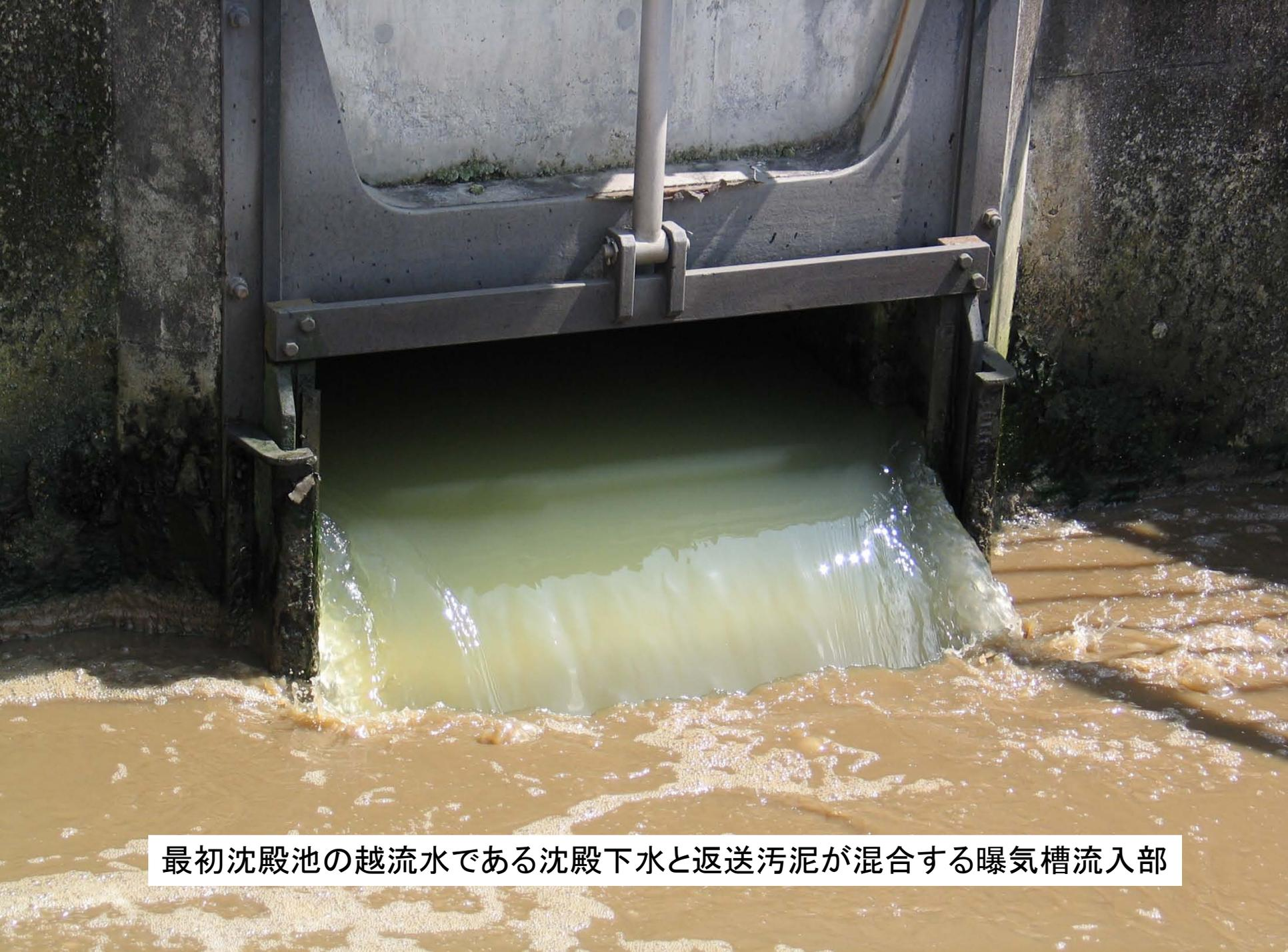
最初沈殿池の越流水である沈殿下水と返送汚泥が混合する曝気槽流入部
