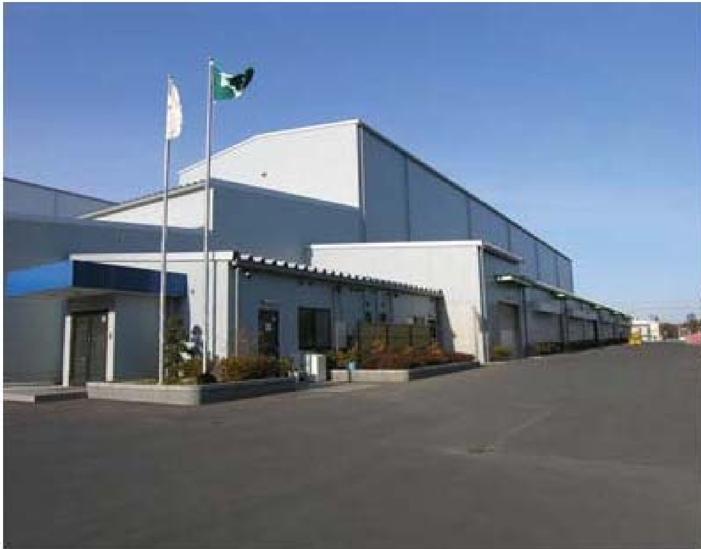
第1図 アイル・クリーンテックのプラント外景 寄居工場
