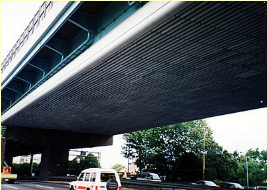
桁下裏面吸音板
