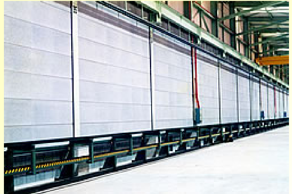
工場建屋内防音
