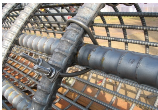
取り付け状況
