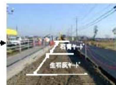
試験施工ヤード 路床
