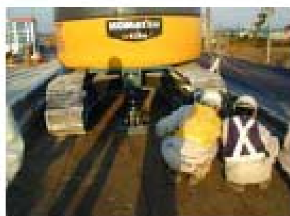
現場CBR試験
