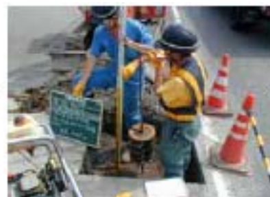
着工前 サウンディング試験
