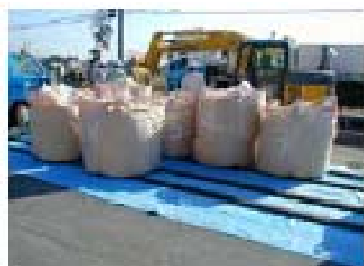
生石灰 (カ 車上に積み込)
