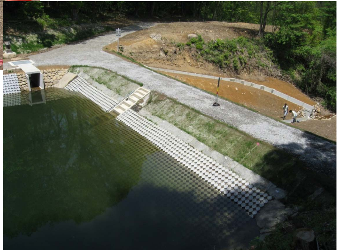
写真下： 完成した築堤 2007年春撮影
