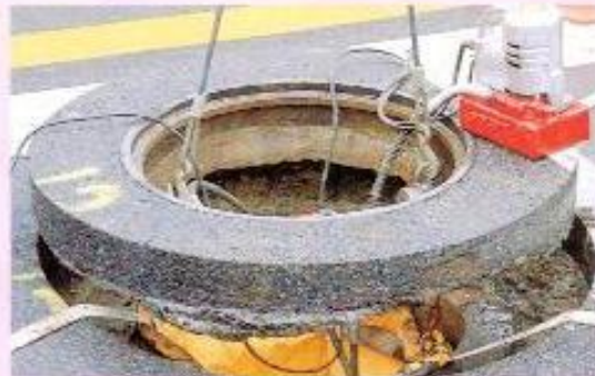
⑤ 吊り上げ撤去
