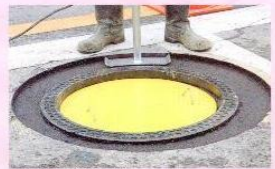
⑨ 円弧転圧機による ESモルタル打設
