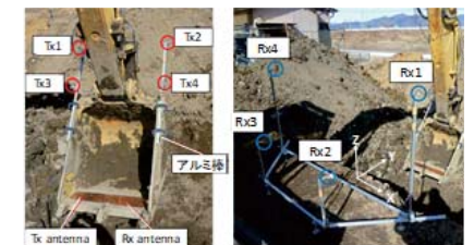
図3 バケット型レーダの現場計測例
